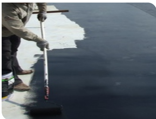
Thi công lớp 2
