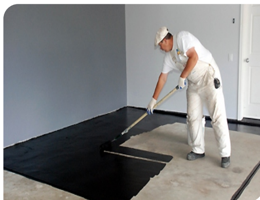
Thi công lớp 1
