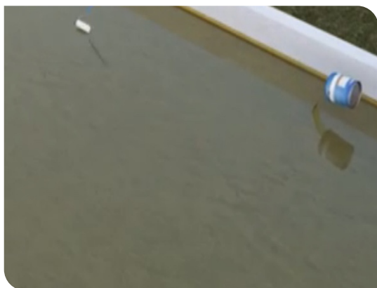
Thi công lớp lót
