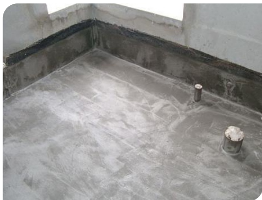
Vệ sinh xịt rửa bề mặt
